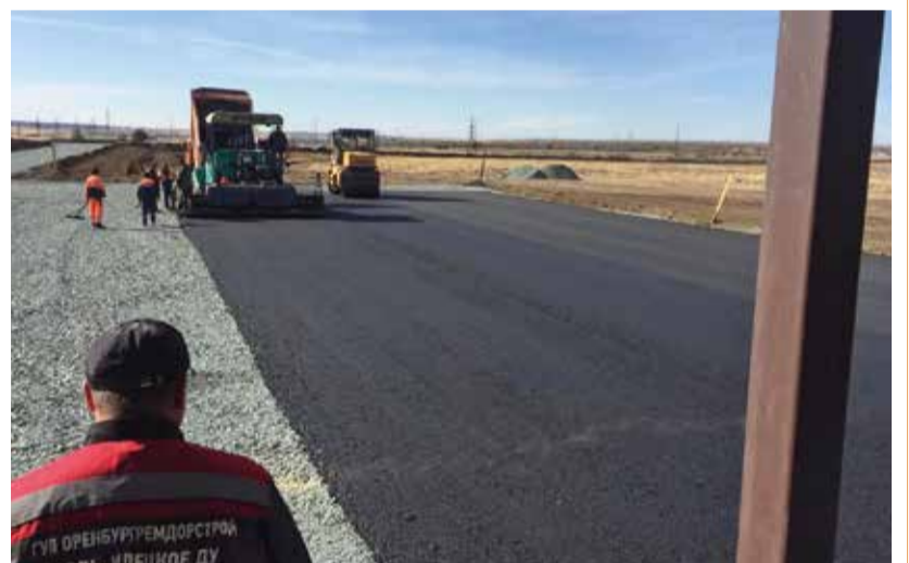
Средства на строительство дороги выделены из федерального бюджета в рамках поддержки моногородов
