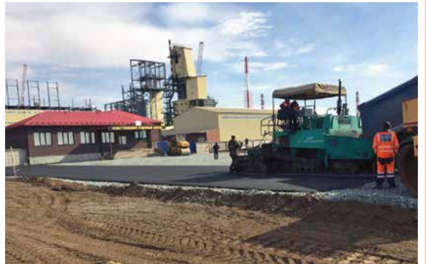
Строительство дороги необходимо для реализации инвестиционного проекта «Новотроицкий содовый завод»
